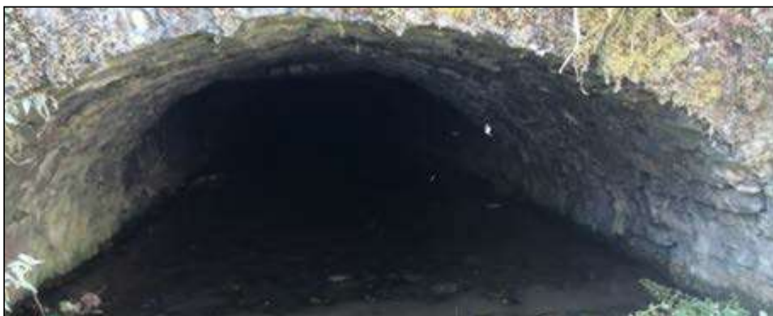
La voûte à l'entrée Nord.
