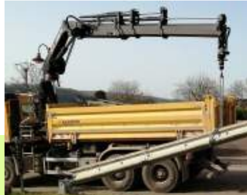
Démontage poteaux électriques
