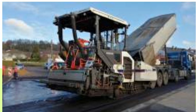
Le finisseur de la chaussée à l'œuvre
