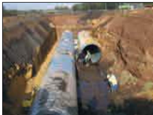
Vue des réservoirs lors de leur installation
