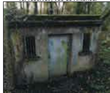
En 1958, 2ème réservoir 500 m 3
