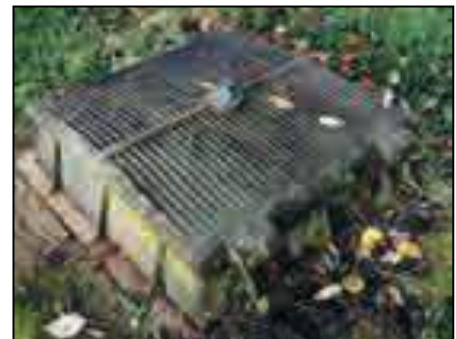
En 1912, 1er réservoir 300 m 3
